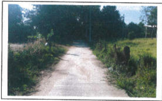
กม. ....๐..+..๑๐๐..... (สภาพสายทางโดยทั่วไป)
