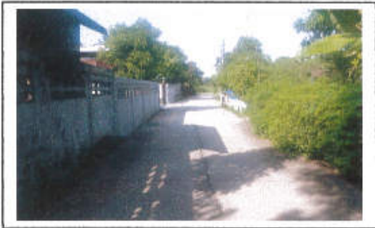
กม. ....๐..+..๑๖๐..... (สภาพสายทางโดยทั่วไป)
