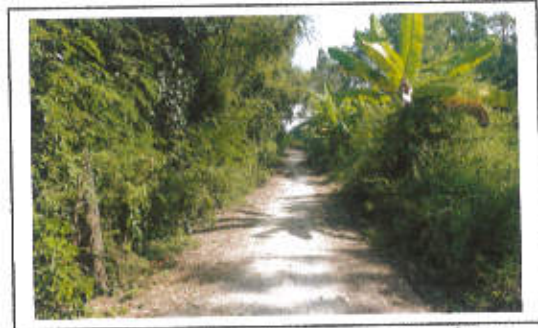
กม. ....๐..+..๒๕๐..... (สภาพสายทางโดยทั่วไป)
