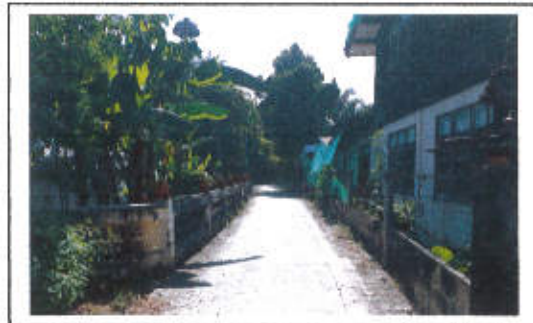
กม. ....๐..+..๐๔๕..... (สภาพสายทางโดยทั่วไป)
