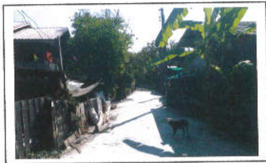
กม. ....๐..+..๑๑๐..... (สภาพสายทางโดยทั่วไป)
