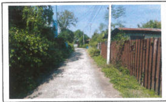
กม. ....๐..+..๑๒๐..... (สภาพสายทางโดยทั่วไป)
