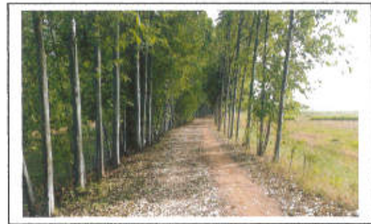
กม. ....๐..+..๒๖๐..... (สภาพสายทางโดยทั่วไป)
