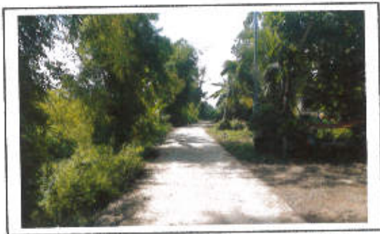
กม. ....๐..+..๓๔๐..... (สภาพสายทางโดยทั่วไป)
