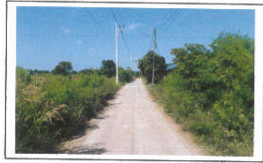
กม. ....๐...+..๓๐๐..... (สภาพสายทางโดยทั่วไป)
