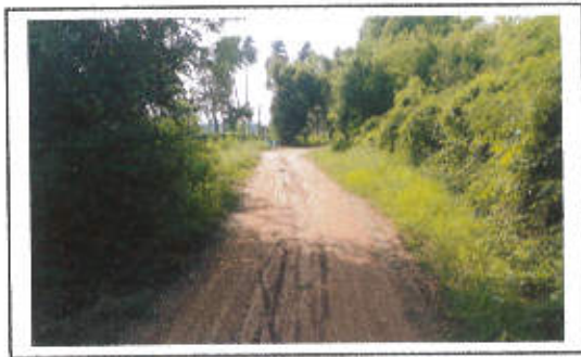
กม. ....๐..+..๒๘๐..... (สภาพสายทางโดยทั่วไป)
