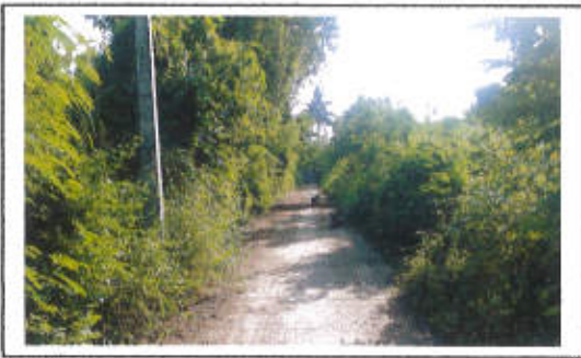
กม. ....+..... (สภาพสายทางโดยทั่วไป)
