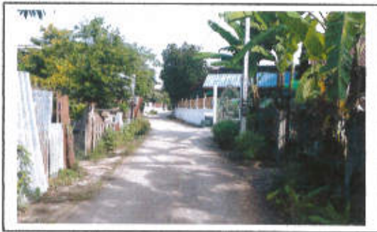
กม. ....๐..+..๒๐๐..... (สภาพสายทางโดยทั่วไป)
