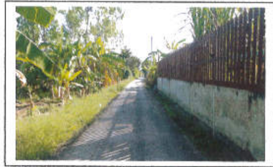
กม. ....๐..+..๑๐๐..... (สภาพสายทางโดยทั่วไป)
