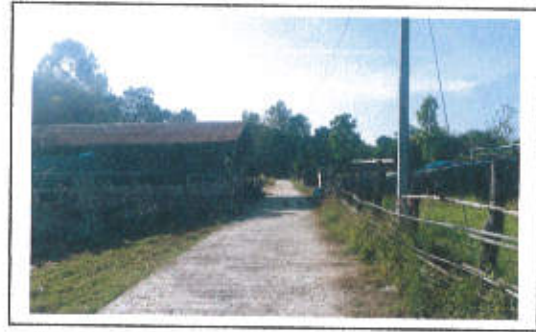
กม. ....๐..+..๐๖๐..... (สภาพสายทางโดยทั่วไป)
