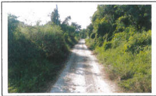
กม. ....๐..+..๐๔๐..... (สภาพสายทางโดยทั่วไป)
