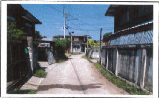
กม. ....๐..+..๑๔๐..... (สภาพสายทางโดยทั่วไป)
